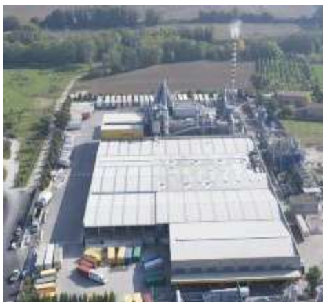
Figura 11: Impianto di termovalorizzazione in via Zotti
