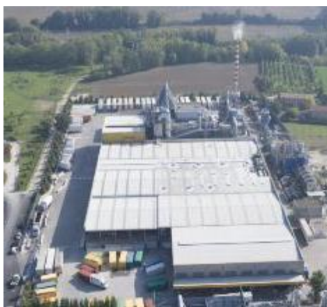
Figura 11: Impianto di termovalorizzazione in via Zotti
