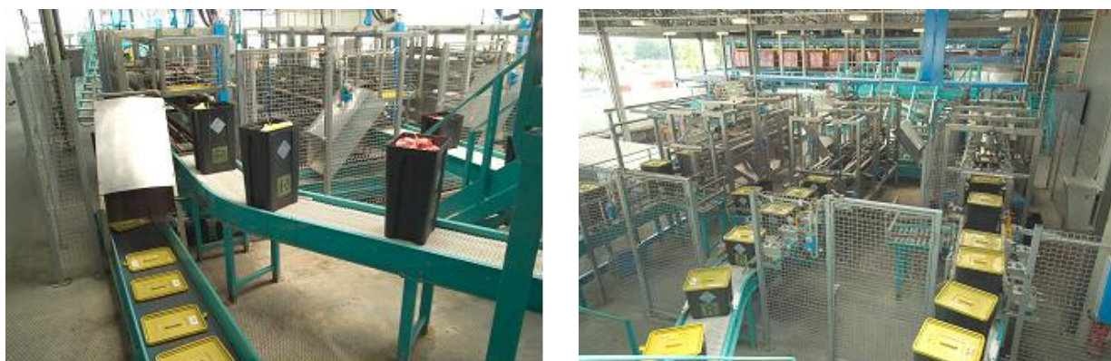
Figura 8: Sistema di movimentazione automatizzata dei contenitori
