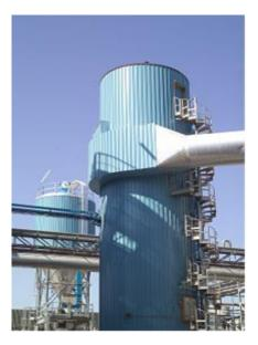
I fumi passano attraverso numerose apparecchiature dove gli inquinanti vengono abbattuti mediante sistemi a secco e a umido. I fumi depurati sono quindi convogliati al camino per l'emissione in atmosfera.
