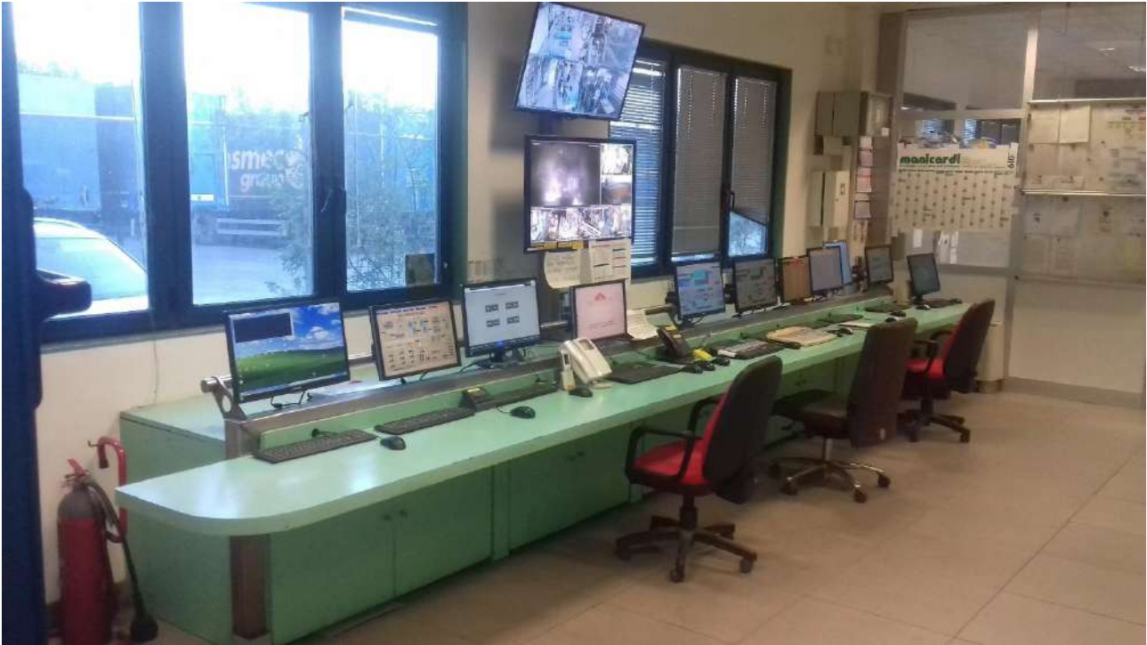
Figura 5: Sala controllo impianto di termovalorizzazione
