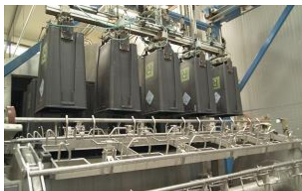
Figura 4: Posizionamento dei contenitori nei cestelli della lavacontenitori
