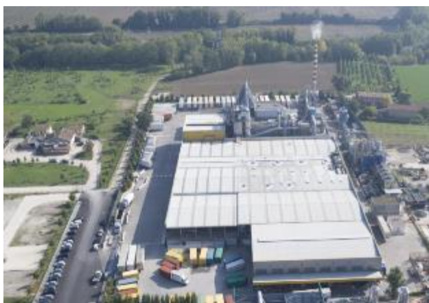
Figura 11: Impianto di termovalorizzazione in via Zotti
