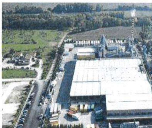
Figura 11: Impianto di termovalorizzazione in via Zotti
